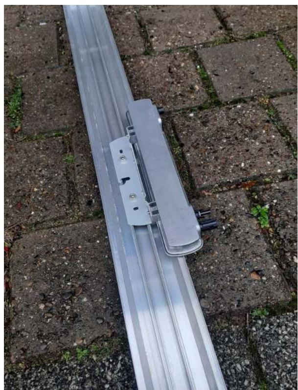
Das Windleitblech wird an den dünnen Stellen an der Aufständerung angebracht. Hierfür muss vorgebohrt werden.
