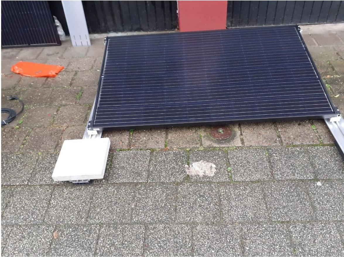
Zum Abschluss werden die Schienen mit genügend Gehwegplatten beschwert. Hierfür können die kurzen Speedporter auf die Schienen aufgesteckt werden, oder lange, winkelförmige Dome-Porter-Schienen zwischen den beiden auf dem Boden liegenden Schienen angeschraubt werden.
