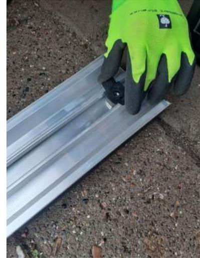
Anschließend wurden die Modultrageelemente vorne in die Schiene eingelegt.
