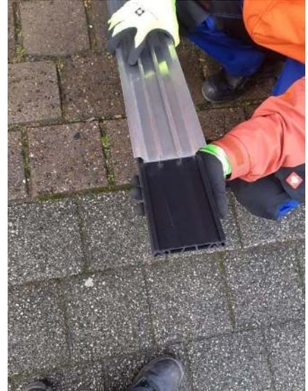
Die Aufständerungen wurden dann hinten mit einer Einlegemutter und Schraube an der Schiene befestigt. Es gibt auch Aufständerungen, die sich unter ein bereits an der Schiene festgeschraubtes Bauteil drunterstecken lassen. Sie rasten dann mit einem lauten Klacken ein. Die Schraube muss danach allerdings nochmal überprüft werden, dass sie wirklich fest zugezogen ist.
