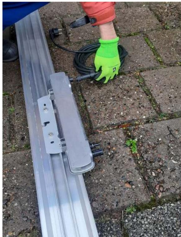
**WICHTIG:** Pro Schiene müssen die Module mit rund 50 kg beschwert werden! Dies ist als Richtwert zu verstehen. Die genaue Beschwerung ist von Windverhältnissen und der Dachsituation abhängig. In jedem Fall müssen die Windleitbleche aus Sicherheitsgründen angebracht werden.
