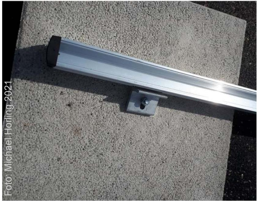
Zur Befestigung wurde an der Unterseite der Gehwegplatte eine Unterlegscheibe angebracht. Auf der Oberseite wurde die L-förmige Befestigung für die Profilschiene mit einer Mutter und ebenfalls einer Unterlegscheibe befestigt. Die Enden der Schienen wurden mit den schwarzen Kunststoffkappen geschützt.
