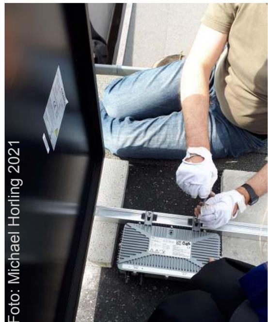
Die MC4-Stecker der Modulkabel sind verpolungssicher, das heißt, hierbei kann kein falsches Einstecken passieren.
